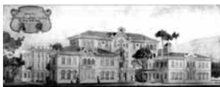
HOSPITAL DA FUNDAÇÃO GAFFRÉE E GUINLE, FACHADA PRINCIPAL, PROJETO PORTO D'AVE E HAERING, ENG A E ARCH OS
